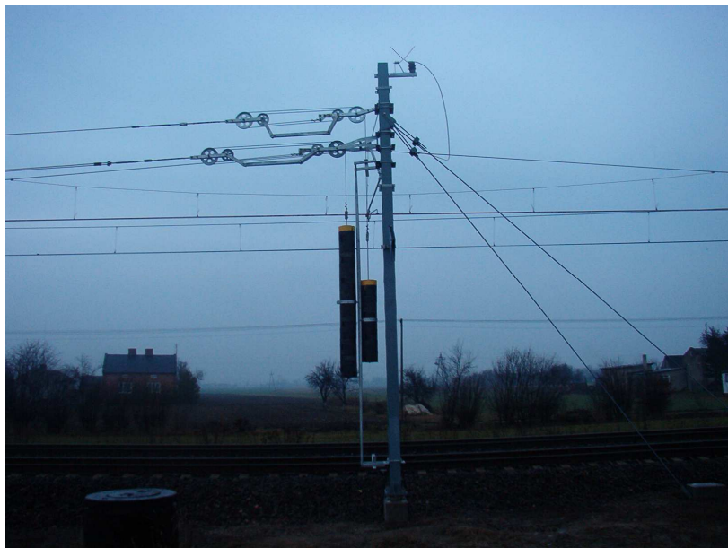
Rys. 4 Urządzenie naprężające linowe rozdzielone o przekładni 1:4 wyposażone w obciążniki z betonu polimerowego
