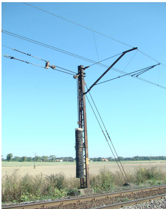
Rys. 2 Urządzenie naprężające łańcuchowe o przekładni 1:2
