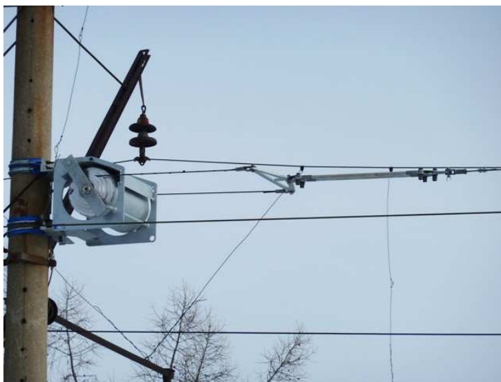
Rys. 7 Urządzenie naprężające sprężynowe rosyjskie
