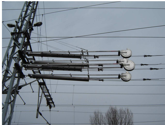
Rys. 6 Urządzenia naprężające firmy PFISTERER ze sprężyną śrubową stalową kotwione do wspólnej bramki
